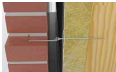
Montage av kramla i murverkets liggfog. Horizontalsnitt.
